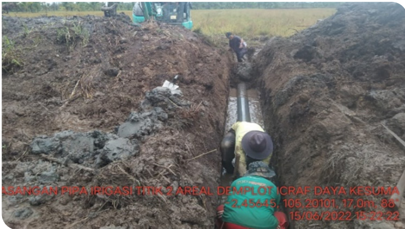
Gambar 11. Pemasangan paralon untuk sebagai pengatur tata air dari lahan ke saluran tersier pada musim hujan dan sebaliknya dari saluran tersier ke lahan pada musim kemarau (© Romadhona Hartiyadi/ICRAF-Indonesia)
