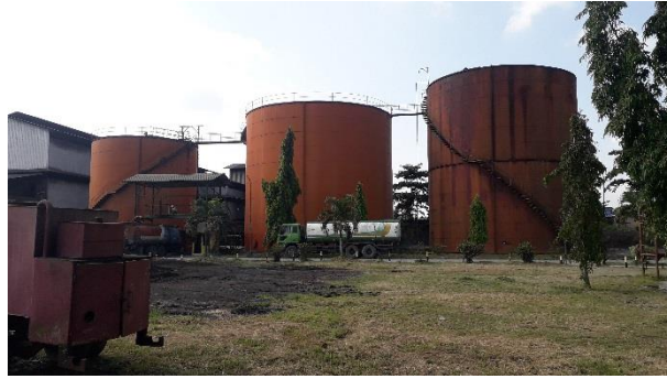
Gambar 41. Tangki Timbun CPO Milik PKS PT. Serba Huta Jaya dengan Kapasitas Total Mencapai 8.100 ton
