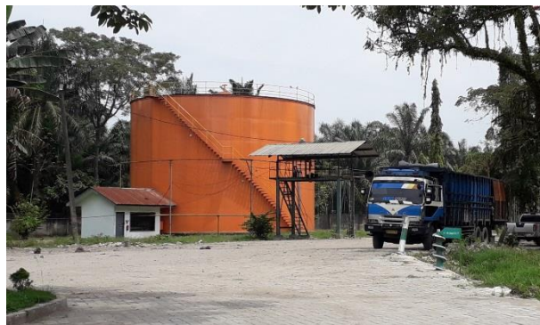
Gambar 40. Salah Satu Tangki Timbun CPO Milik PKS PT. Merbaujaya Indahraya dengan Kapasitas 2.000 ton
