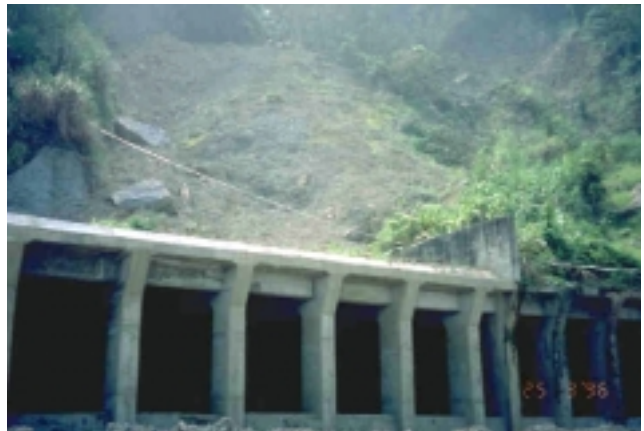
Gambar 11.4. Contoh konstruksi penanggulangan longsor yang memerlukan teknologi tinggi dan biaya mahal.
