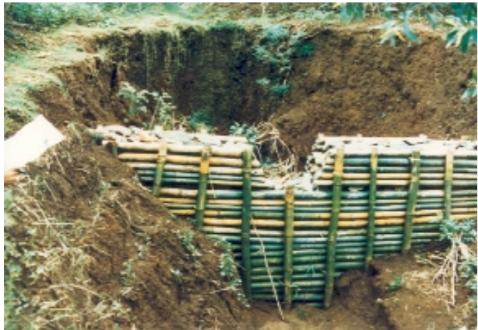
Gambar 11.5. Bangunan penahan 'longsor kecil' dari bambu. Foto: Widiyanto
