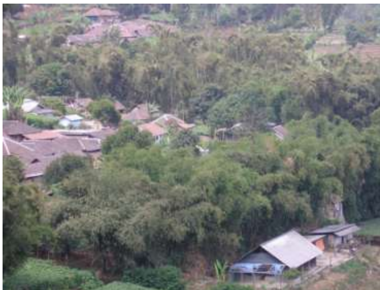
Gambar 3.6. Kawasan Pemukiman dan/atau tertutup oleh Bangunan
